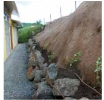
Onnistuneesti asennettu GREENFIX Rockmat type 6D Uudessa Caledoniassa.
